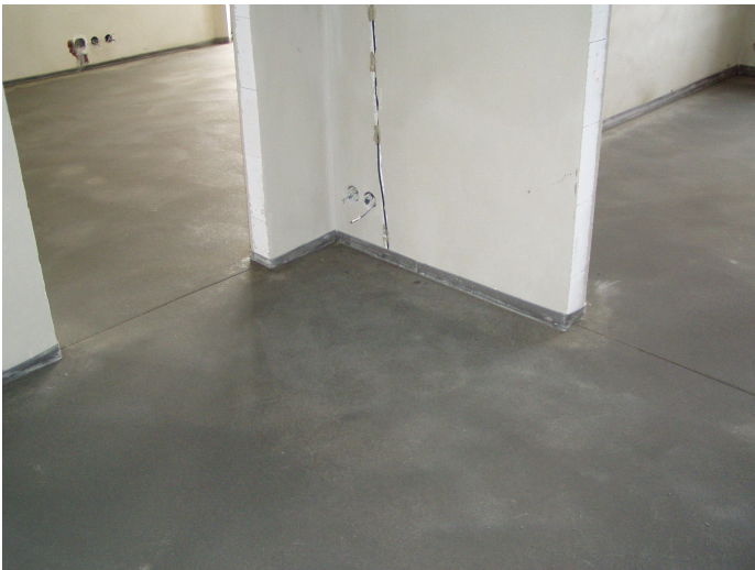
Pohled na hotové potěry v bytovém domě s provedenými dilatačními spárami, po odkrytí PE fólie
