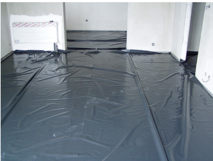
Zakrytí potěru PE fólií po provedení betonáže
